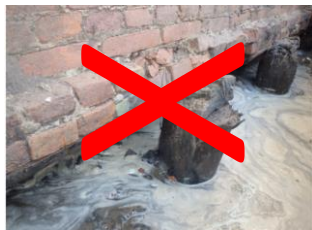
Funderingsschade (palen en op staal gefundeerd)
